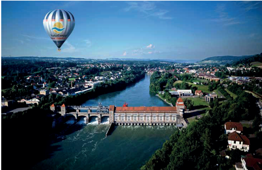
Meilenstein in der europäischen Stromgeschichte: Wasserkraftwerk Laufenburg am Hochrhein.
